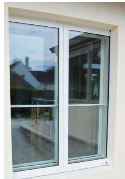
Figure 22 : Couissant enclouonné dans l'ITE
