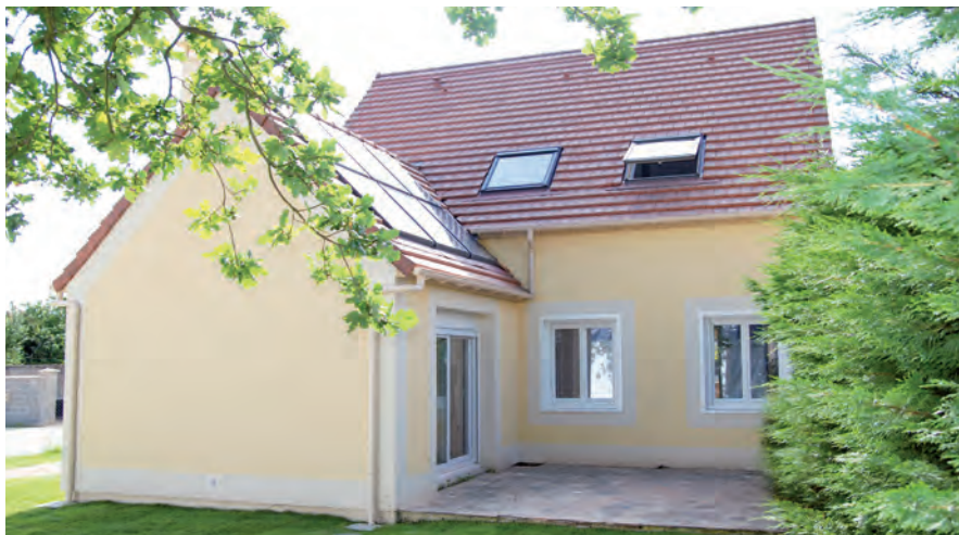
Figure 24 : Maison rénovée « Facteur 4 »
