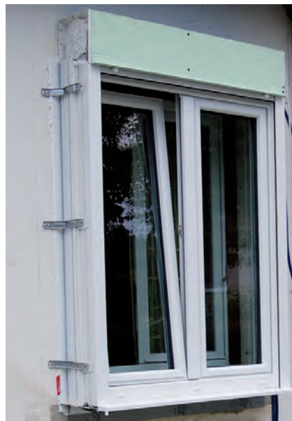
Figure 21 : Menuiserie PVC SI 82+ triple vitrage et volets roulants, pose en ITE
