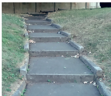
Figure 22.3 : Les volées de marches de type « pas d'âne » ne peuvent être empruntées par le public circulant en fauteuil roulant ou avec un déambulateur et doivent être doublées d'un autre cheminement accessible
