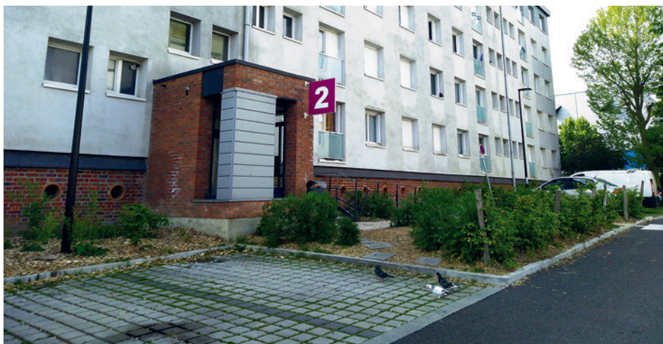
Figure 27.1 : Entrée visuellement repérable d'un bâtiment d'habitation collectif
