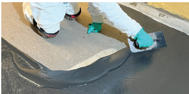
Figure 50 : Application de la couche de masse à la lisseuse
