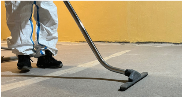
Figure 49 : Aspiration mécanique de l'excès de sable
