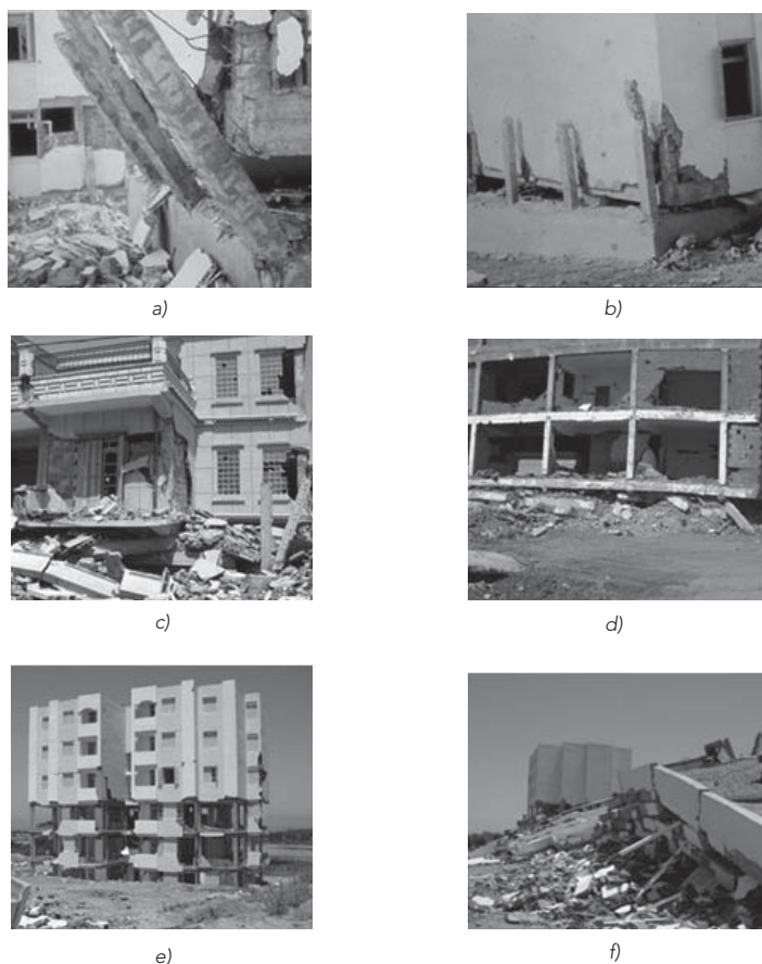
Figure 9 : Séisme de Boumerdès : destruction des niveaux inférieurs
