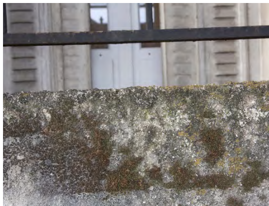
Figure 10 : Salissures d'origine biologique : présence de mousses et micro-organismes
