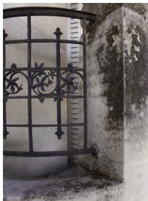
Figure 11 : Salissures d'origines physique et biologique
