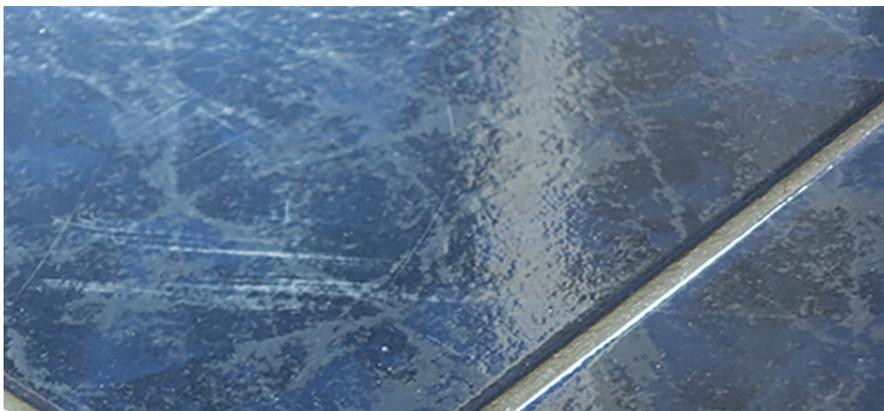
Figure 5 : Carrelage rayé de salle de bains
