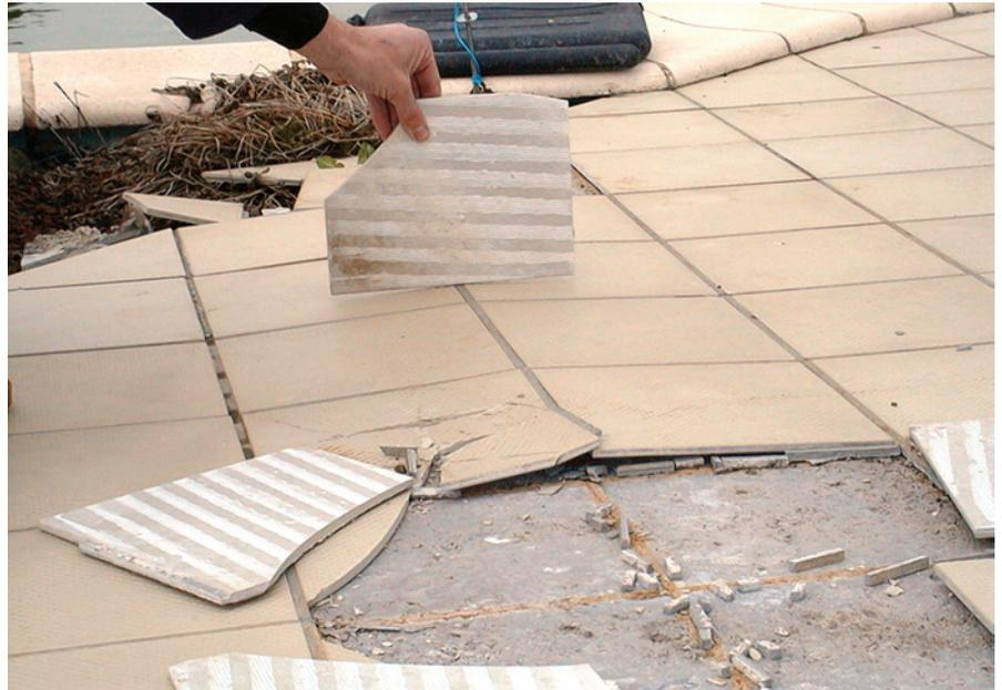
Figure 14 : Soulèvement d'un carrelage collé
