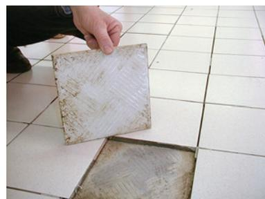
Figure 42 : Descellement, pas de « transfert » de la barbotine dans le carreau.
