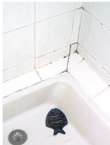
Figure 5 : Joints mal entretenus dans une douche
