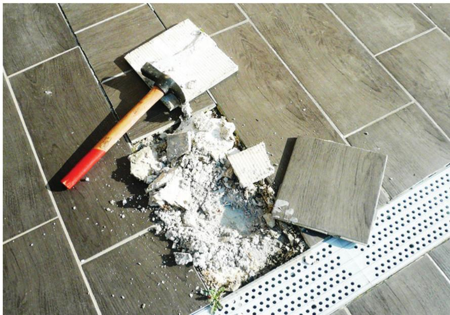
Figure 18 : En partie basse de cette terrasse, le sondage révèle le caractère anormalement pulvérulent du mortier colle, délavé par la pluie.
