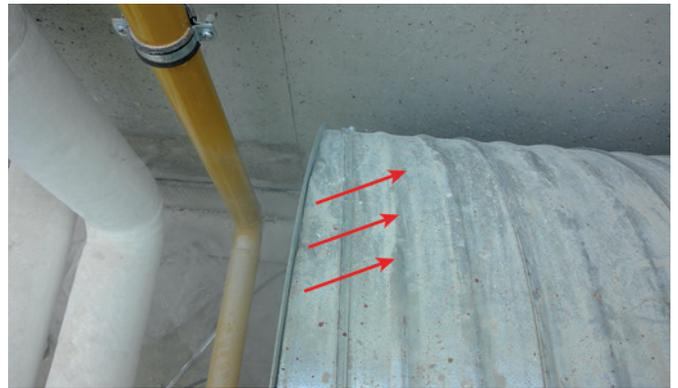
Figure 29 : Fuite au niveau du bouchon
