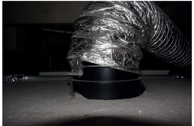
Figure 28 : Fuite au niveau du raccordement entre diffuseur et manchette
