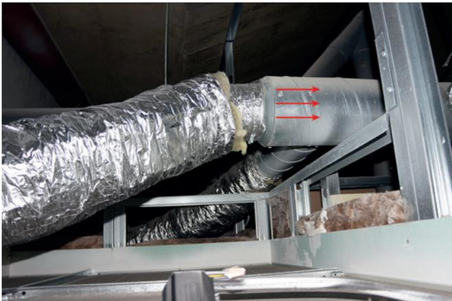
Figure 27 : Fuite au niveau d'un raccord avec un conduit flexible
