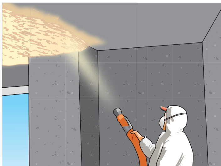
Figure 4 : Projection d'isolant en sous face de plancher
