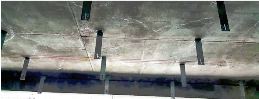
Figure 5 : Exemple de préparation du support
