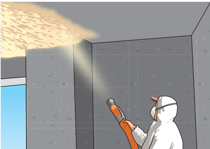
Figure 6 : Projection d'isolant en sous face de plancher bas
