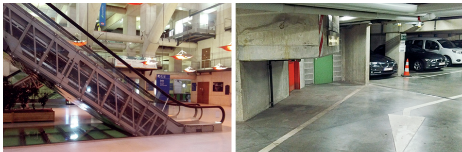
Figure 10.1 : Des exemples d'obstacles en hauteur dans les circulations
