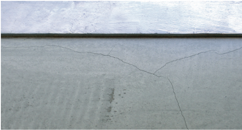
Figure 9 : Apparition de fissure de la chape : bâtiment non clos durant le coulage et le séchage
