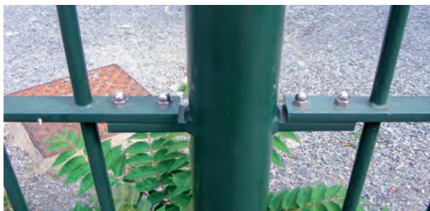
Figure 56 : Détail de pose d'un barreaudage industriel par boulons inox
