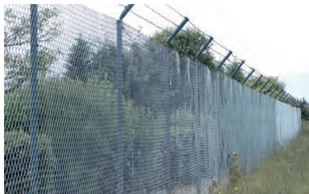
Figure 42 : Simple torsion lourd défensif en inox, avec poteaux acier tous les 2,50 m et bavolets de fils de ronce
