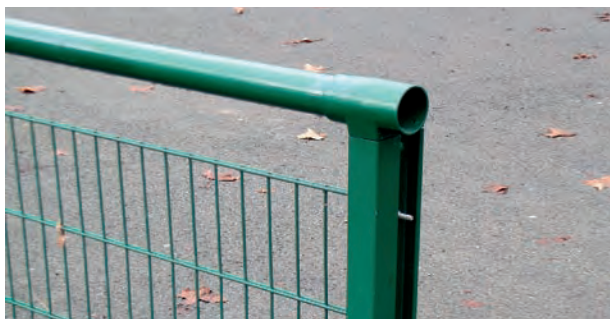
Figure 57 : Lisse métallique bifil en limite d'un parc de stationnement
