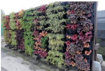
Figure 6 : Présentation des modules préformés pour mur végétalisé
