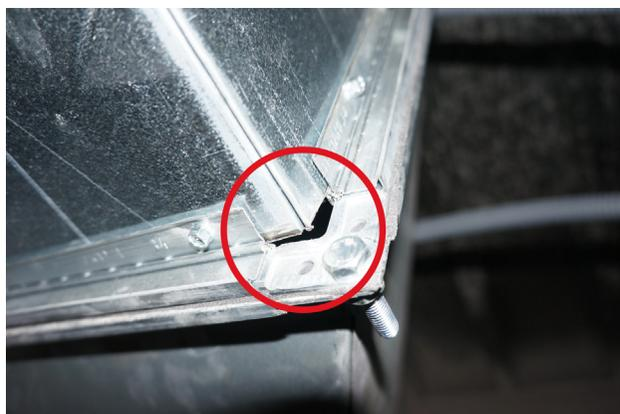
Figure 3 : Défaut de raccord entre conduits au niveau des contre-cadres de réseau rectangulaire
