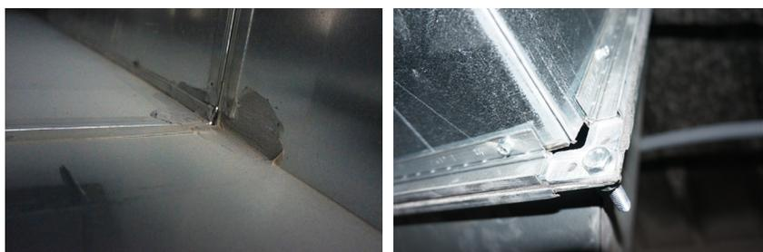
Figure 1 : Connexion bord à bord entre réseaux rectangulaires
