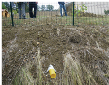
Figure 19 : Drain agricole utilisé à mauvais escient pour une construction. Le sommet de la tranchée a été remblayé avec des déblais issus du terrain argileux. Avec un remblai de ce type, les eaux superficielles de ruissellement vont passer par-dessus le drain au lieu de s'y infiltrer, vont buter contre la construction et hydrater l'assise des semelles de fondation, voire inonder le vide sanitaire.
