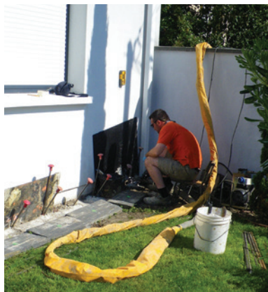
Figure 73 : Plusieurs niveaux d'injection sont nécessaires dans la partie sinistrée
