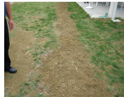
Figure 19 : Drain agricole utilisé à mauvais escient pour une construction. Le sommet de la tranchée a été remblayé avec des déblais issus du terrain argileux. Avec un remblai de ce type, les eaux superficielles de ruissellement vont passer par-dessus le drain au lieu de s'y infiltrer, vont buter contre la construction et hydrater l'assise des semelles de fondation, voire inonder le vide sanitaire.
