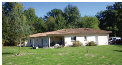
Figure 184 : Vue générale depuis l'ouest avec la végétation haute tige en arrière-plan.
