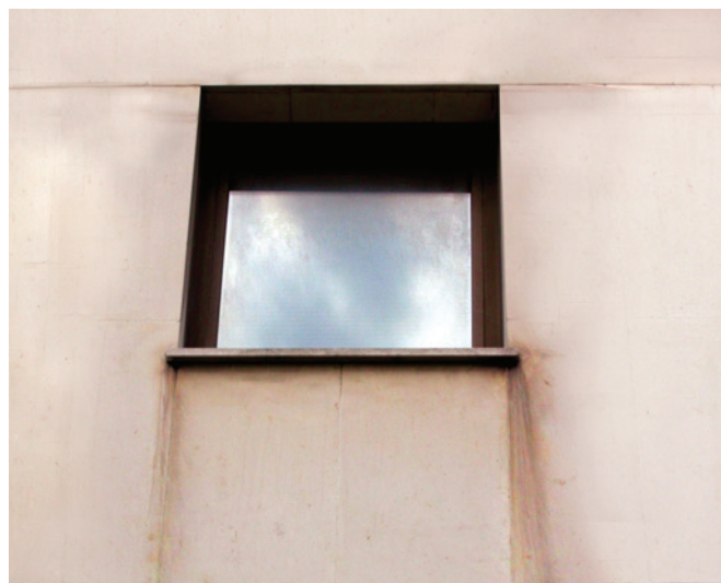
Figure 23 : Moustaches aux extrémités d'un appui
