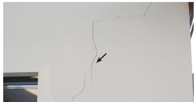
Figure 103 : Retrait de la poutre formant linteau. La poutre ou plutôt son extrémité a arraché la maçonnerie.
