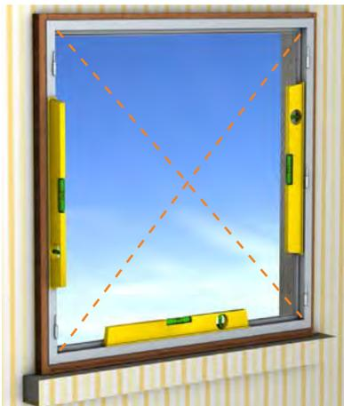
Figure 2 : Vérification verticalité et horizontalité
