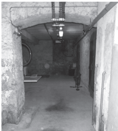
Figure 3 : Dallage béton armé du couloir de la cave
